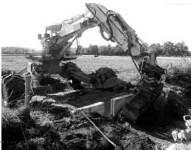
Wiederanfüllen der Böschung
