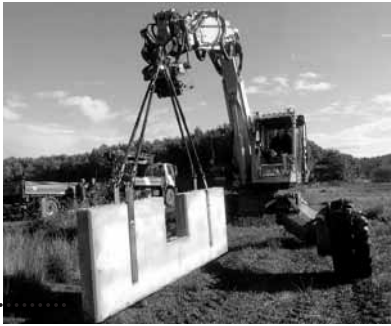
Der Schreitbagger mit dem vorgefertigten Beton-Stauwehr
