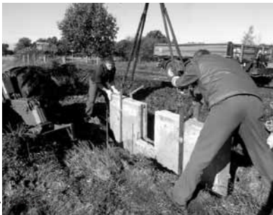
Das schwere Bauwerk wird passgenau in das vorbereitete Fundament eingelassen.
