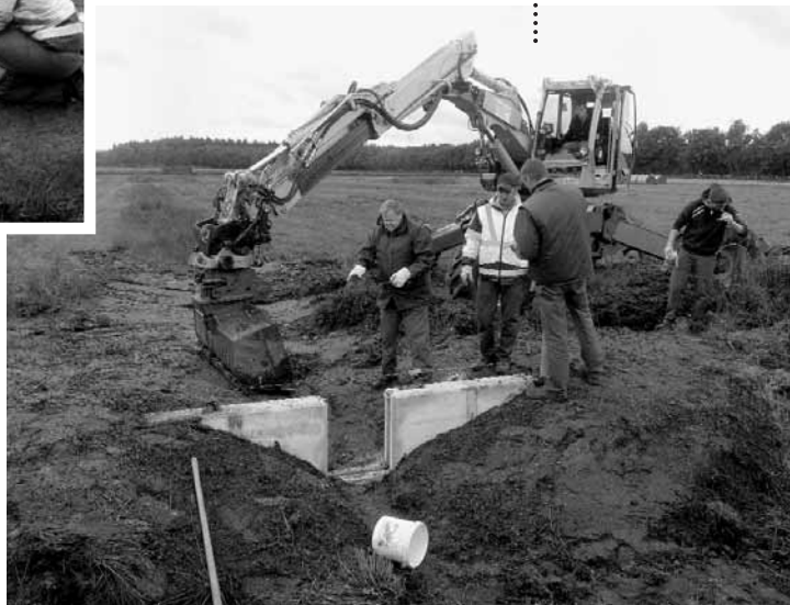
Das fertig eingebaute Stauwehr im Lüsekamp
