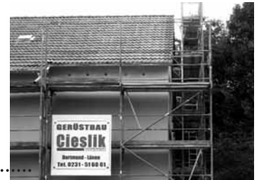
5 Mauerseglerkästen WDV 1a am Gebäude Stettiner Straße 88 in Krefeld
