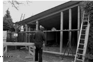
Das Dach ist fertig.
