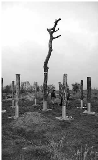
Ein sicherer Ort: Der Pavillon mitten in der Naturarena bekommt ein Fundament. Foto: Helga Westerhuis
